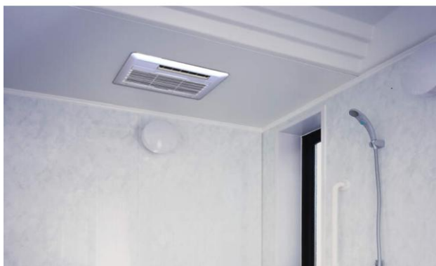
浴室の天井に設置
