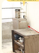
給湯器設置前
